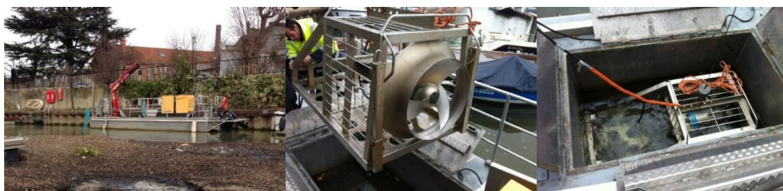
Figure 15 : Exemple d'hydro-propulseur (Joinville le Pont)
