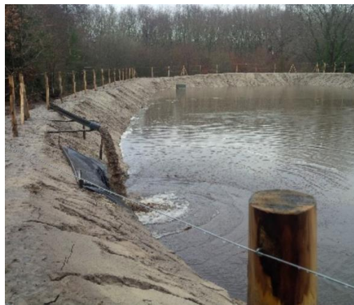
Figure 12 : Exemple de rejet en bassin de décantation
