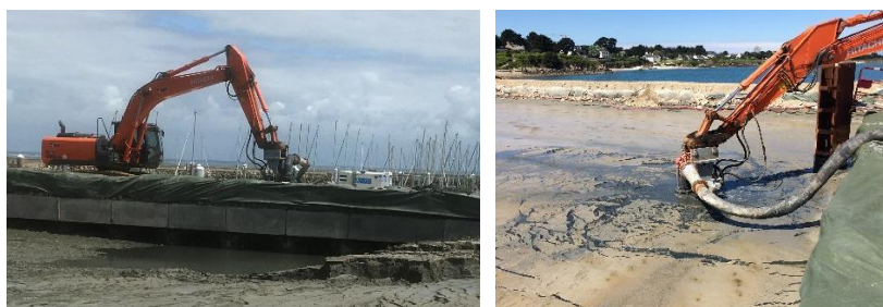
Figure 17 : Exemple d'un pompage depuis l'extrémité d'une pelle mécanique (IDRA, MARC SA, 2019)
