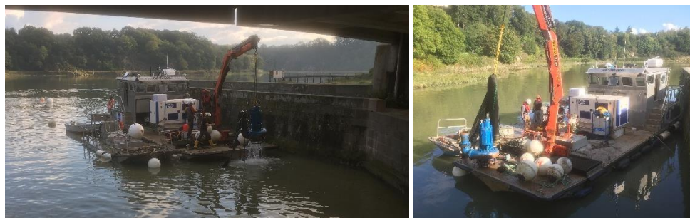
Figure 16 : Exemple d'aspiro-dragage (Lynet / Ecluse du Chatelier, 2017)
