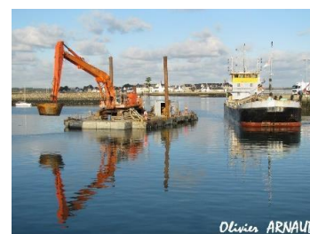
Dispositif ponton-pelle + barge
